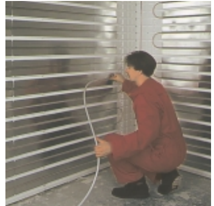
Das PE-Xa Rohr nach Verfahren Engel in der Dim. 14 x 2 mm wird durch das Omegaprofil in der Wärmeleitlamelle sicher gehalten.
