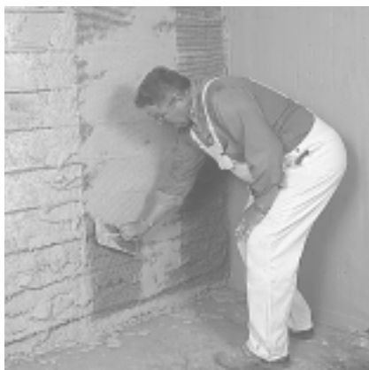
Nass in Nass Verputzung mit Gittermatte aus Kunststoff
